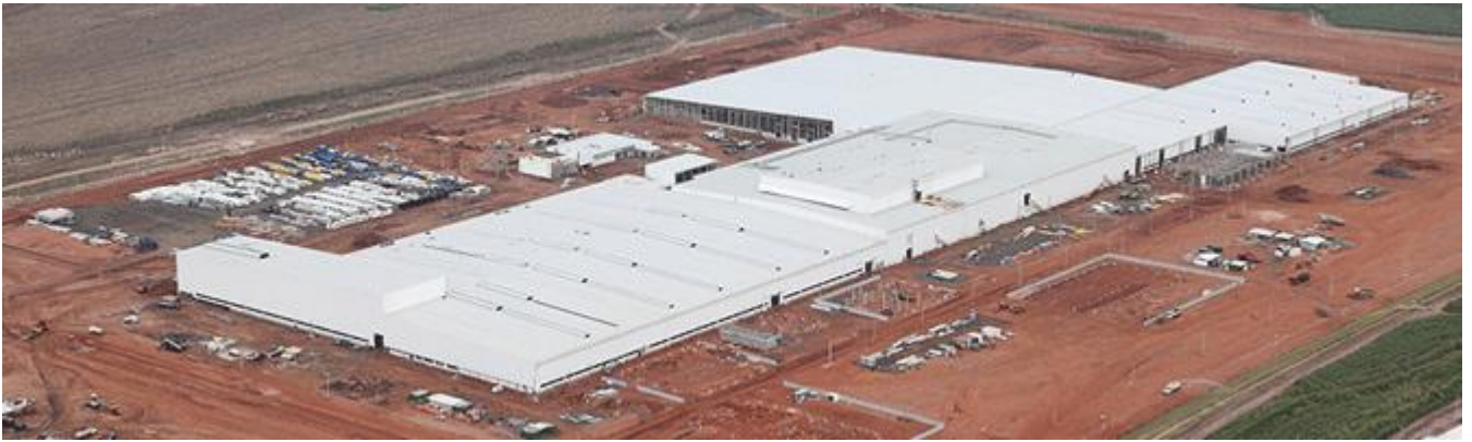
Vista aérea da nova fábrica da Honda em Itirapina (SP)
