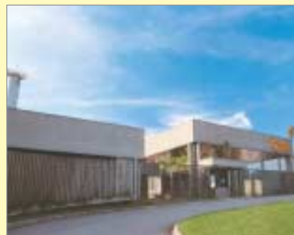
- Fachada da fábrica da Igasa
